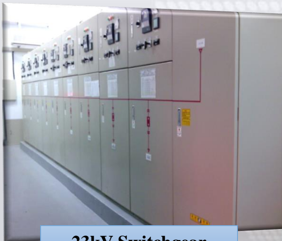
23kV Switchgear
