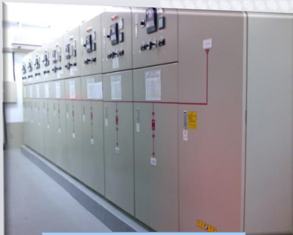
23kV Switchgear
